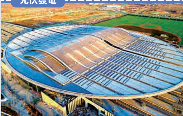
▲雄安站屋頂鋪設了4.2萬平方米光伏建材，使其成為一座會發電的火車站
