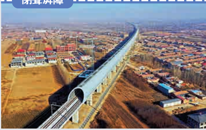
▲全封閉聲屏障設施，外圍採用金屬隔音板單元，可最大程度降低噪聲
