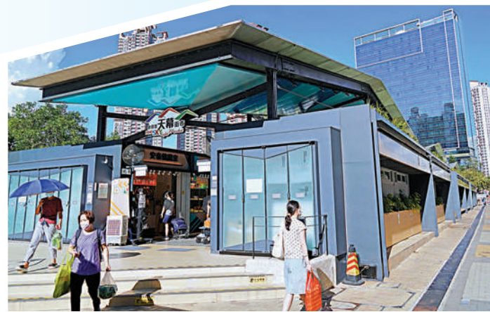
▶高樓底及開放式設計令日光進入室內。大公報記者梁堅攝
