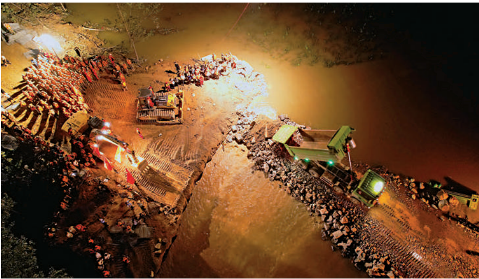
▲昨日，隨着最後一車石料倒入河中，經過兩天兩夜的艱苦奮戰，河南衛河浚縣新鎮鎮河段決口成功合龍。中新社
