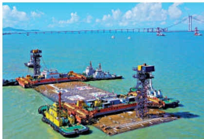
▲深中通道沉管隧道安裝突破六分之五，圖為沉管作業現場。受訪者供圖
