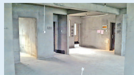
▲毛坯房為未裝修的交樓單位，牆身為水泥牆，地板未鋪砌。
