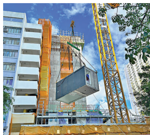
▲沙田乙明邨「松悅樓」是全港首個採用鋼結構MiC興建的長者房屋，預計今年年底落成。
