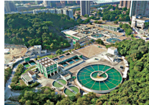
▲屯門濾水廠水力發電站是本港建立的首個水力發電站。
