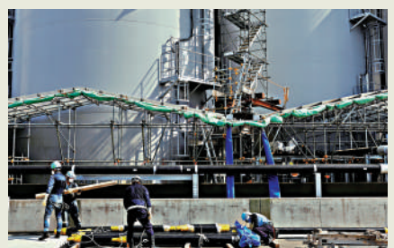
▲工人們3月在福島核電站安裝排污管道。路透社
