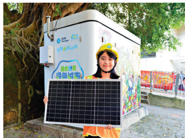
▲煤氣公司「智能調壓站」引入太陽能供電系統，提供可再生電力。
