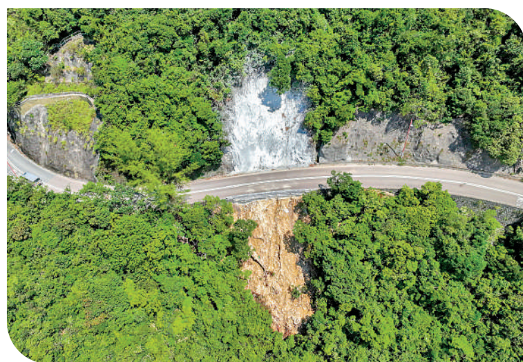
▲石澳道山泥傾瀉的位置已噴漿鞏固。 ◀石澳道倒塌的單車路已堆放石填料支撐。
