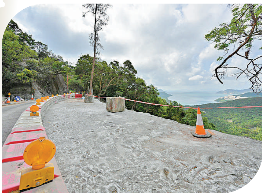
▲石澳道山泥傾瀉的位置已噴漿鞏固。 ◀石澳道倒塌的單車路已堆放石填料支撐。
