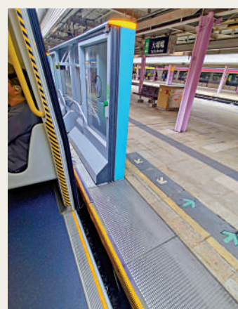
▲大埔墟站月台正加裝閘門。
