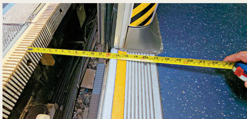
▲大學站月台空隙最寬闊處，加裝膠條之後，仍有30厘米。
