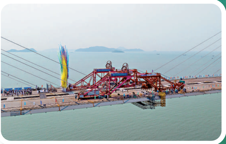
黃茅海跨海通道高欄港大橋合龍樑段。新華社
