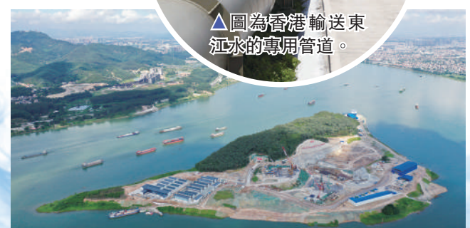
▲今年1月30日，珠江三角洲水資源配置工程正式通水，可作為香港的備用供水。圖為該工程位於佛山的取水口鯉魚洲。
