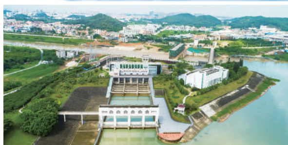
▲太園抽水站是東深供水工程的第一級抽水站取水口。圖為巡檢無人機拍下的畫面。
