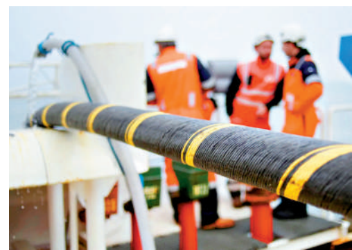
▲海底電纜對全球通訊至關重要。圖為法國工人安裝海底電纜。法新社
