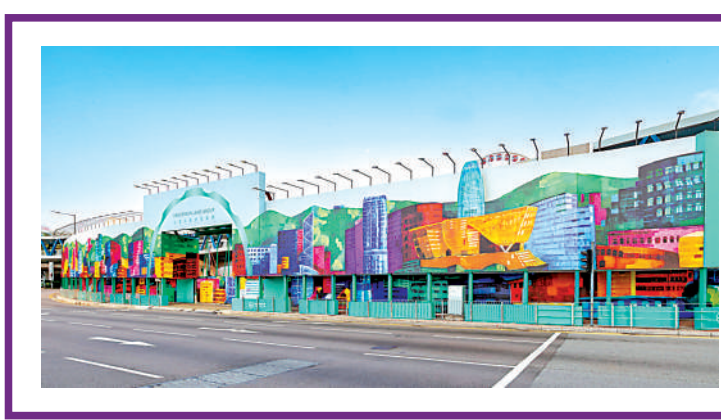
▲中環新海濱三號項目的建築圍板上，現已化身成藝術長廊。
