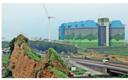
▲由於民進黨當局堅持廢除核電，導致島內供電不足。圖為新北市林口區風力發電設施。
