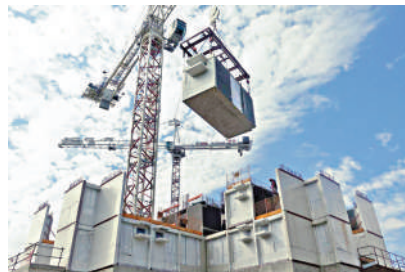
▲港鐵研使用組裝合成建築法興建新車站，加快進度。
