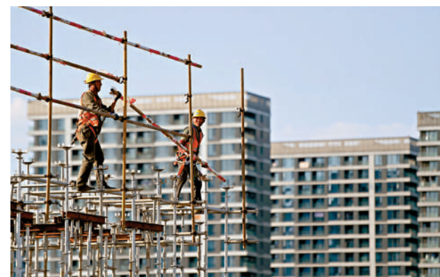
▲業界建議創設「房地產穩定基金」，保障房地產工程建設，提升房企「保交樓」能力。
