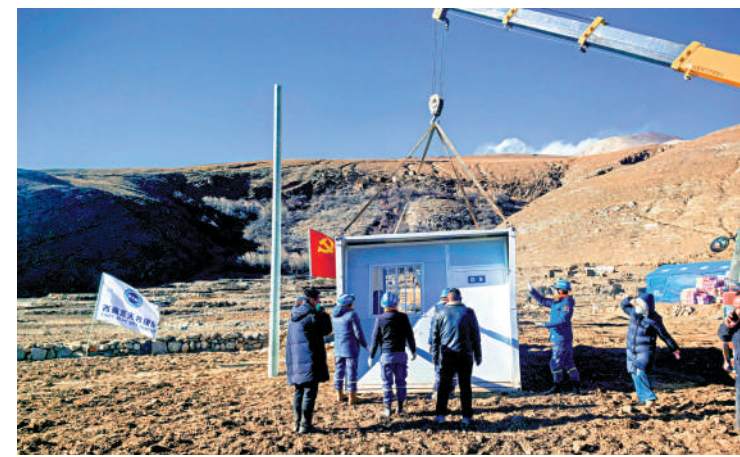
8日，大型機械抵達災區，加速建設條件更好的臨時安置所。
