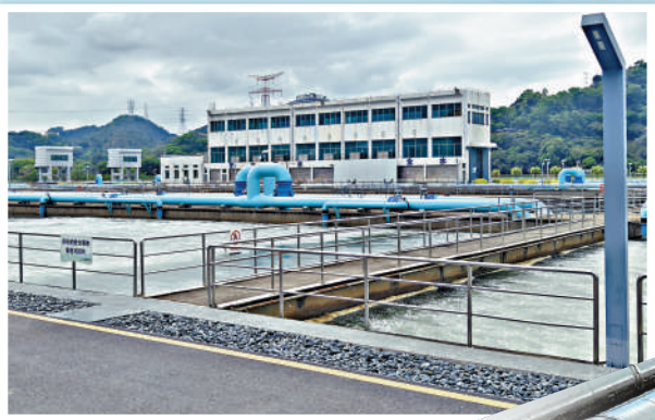
▲深圳水庫設置生物硝化站，每日淨化400萬立方米的水。
