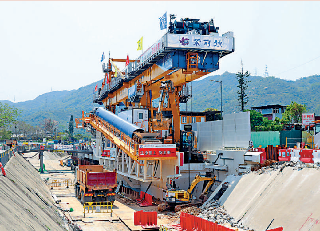
▲翟志恆表示，「紫荊號」實現「單機全流程作業」，支持場外預製再現場拼裝施工模式。
