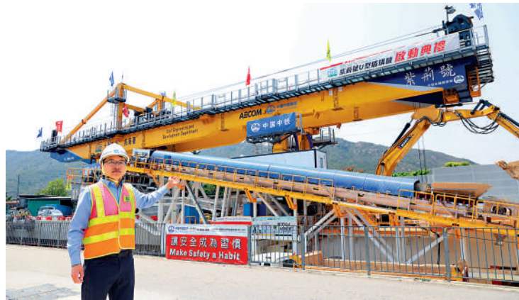
▲「紫荊號」UTBM開創的箱涵施工方法，採用了封閉式掘進與智能拼裝技術。
