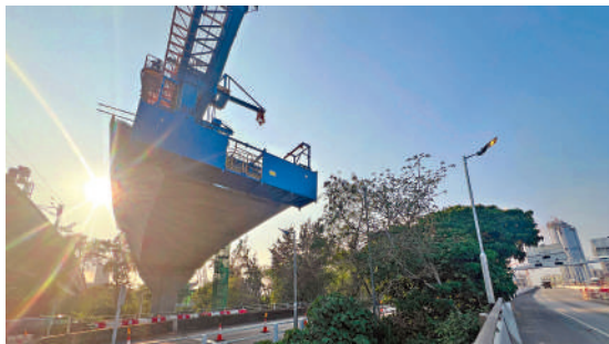
◀落馬洲河套地區的填海工程，成功實現項目使用節段式橋樑，減少對環境的干擾。受訪者對現場供圖。
