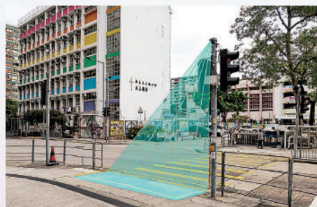
▲運輸署致力改善交通，實時交通燈號調節系統透過雷達感應器及熱能探測器探測實時車輛和行人流量，改善綠燈分配時間，計劃2028年底前在全港合適的路口安裝。
