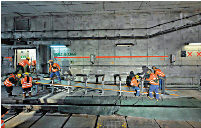
▲古洞站興建工程如火如荼進行中。
