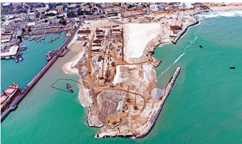
▲在貝寧科托努，中企承建的科托努自治港5號碼頭正在施工。新華社
